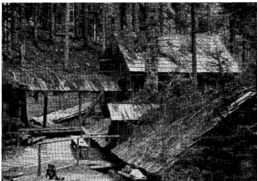
Bolnišnica »Lesen kamen« na Rogu je od ustanovitve, začetek poletja 1943, že v letu dni zrastle v eno največjih postojank. Njena zgradba kaže značilnosti več obdobj. Poletje 1944
